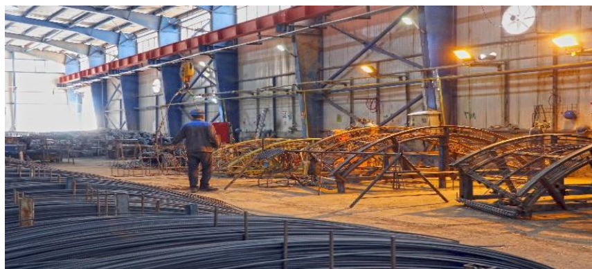
شکل ۲- کارگاه سبدهافی سگمنت
