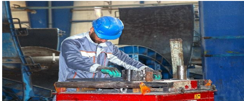
شکل ۷- خم و برش میلگردها به طول و تعداد موردنیاز
