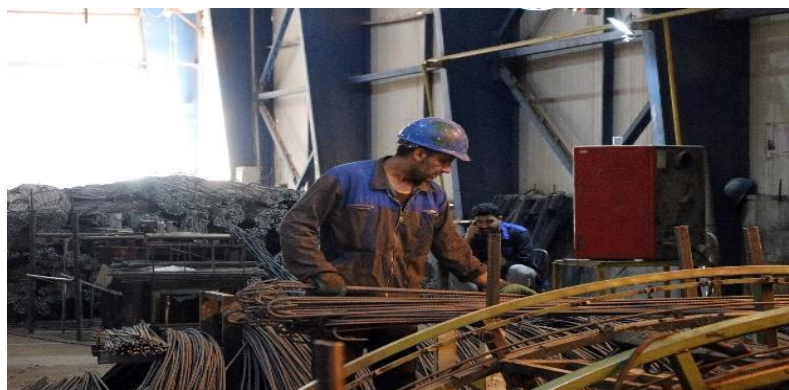
شکل ۵- خم و برش آرماتورها
