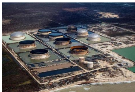
شکل شماره ۳: تصویر آسیب طوفان دوریان به مخازن ذخیره نفت در باهاما [39]
