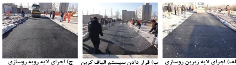
شکل ۴- اجرای سیستم سیم گرمایش الیاف کربن [۱۵].
