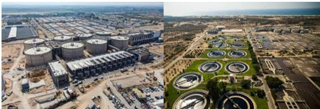
شکل ۳ پروژه اشکول (Shafdan) که توسط رژیم صهیونی به عنوان بزرگترین پروژه فاضلاب در سرزمین‌های اشغالی از یک سیستم پیش‌بینی کننده هوشمند برای مدیریت پارامترهای حفاری استفاده شده است.
