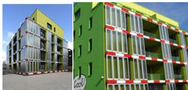
شکل ۳. نمایی از ساختمان BIQ
