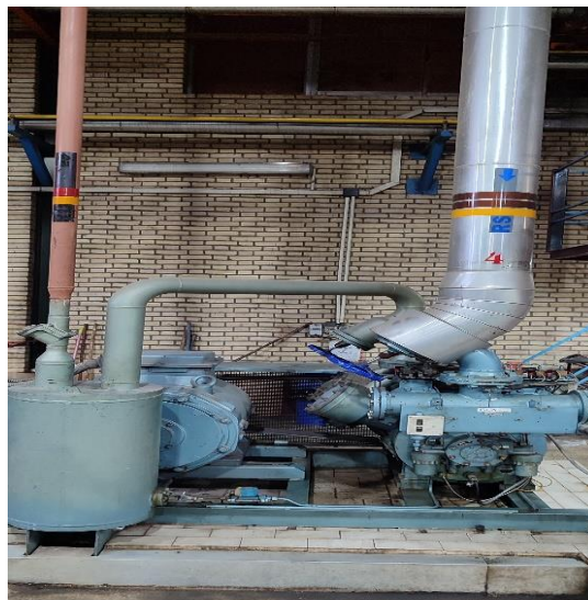
شکل ۱ - نمای تجهیز برودتی کمپرسور دو مرحله ای زیر صفر قبل از تغییرات
