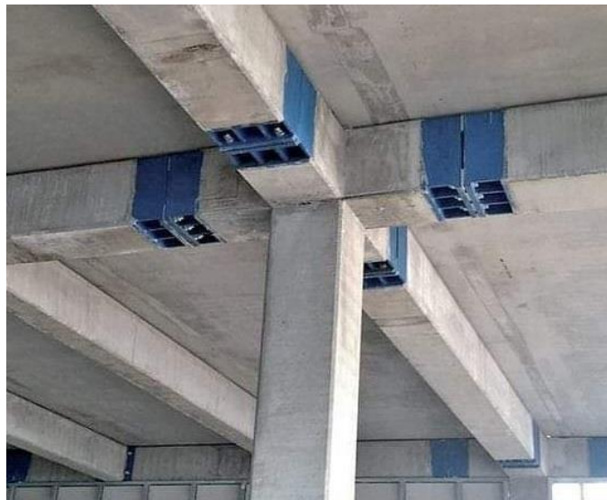
شکل ۱۵ تیر و کفسازی بتنی پیش ساخته
