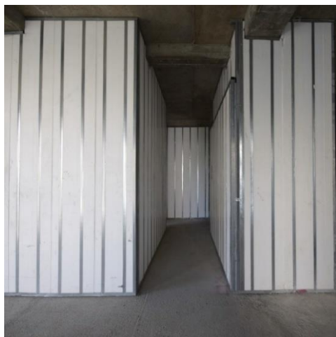
شکل ۱۶ دیوار های پیش ساخته پلی استایرن - تولید شرکت داخلی
