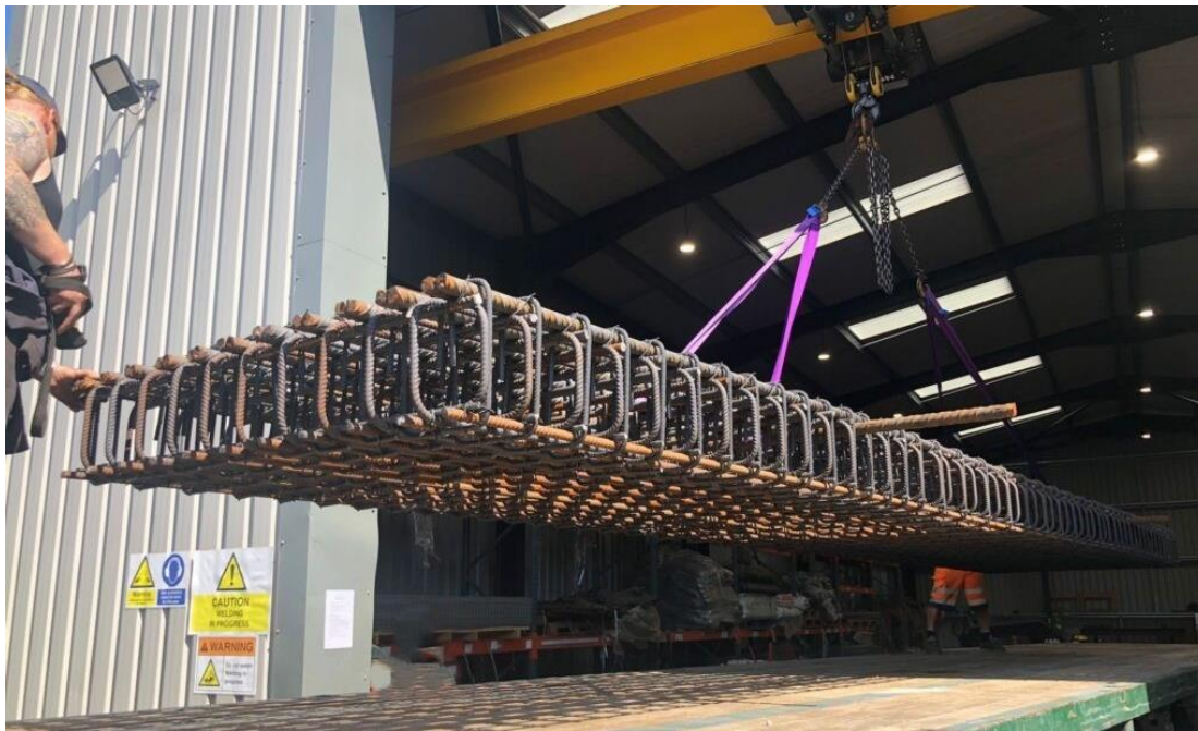
شکل ۱۰ آرماتور بندی پیش ساخته در کارگاه
