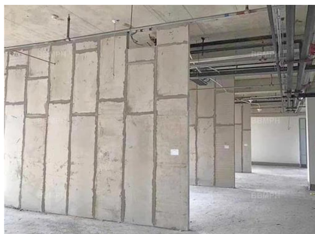
شکل ۱۸ دیوار های پیش ساخته بتنی
