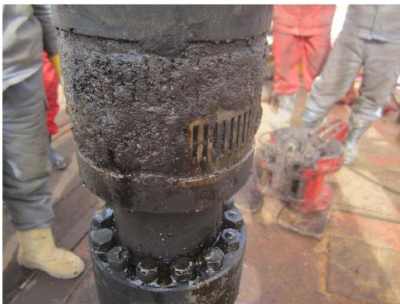
شکل ۲. آسیب به تجهیزات سطحی به علت رسوب آسفالتین [1]
